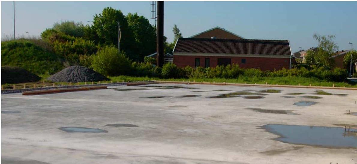
Figur 1 Exempel på nödvändig observation för att beräkningar av vatteninsugning skall bli tillförlitliga: Var har det stått vatten och hur länge? Foto: L-O Nilsson.
